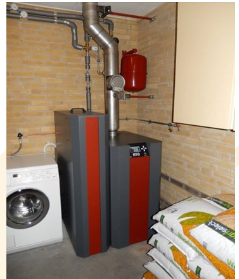
Toepassing van een houtpelletketel bij een particulier te Bemmel.
